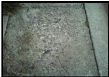
Spalling
